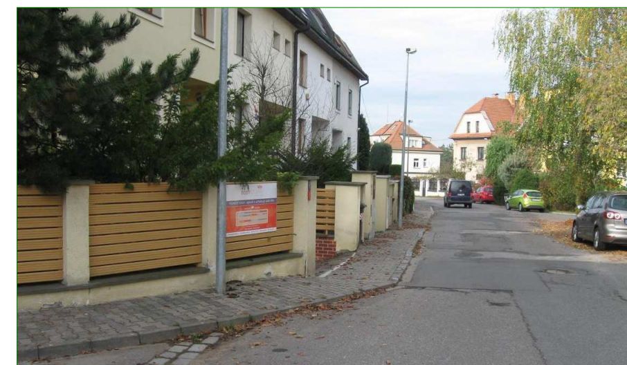
⑥ Psohlavců; nedostatečná šířka vozovky, špatný výhled do zatáčky
