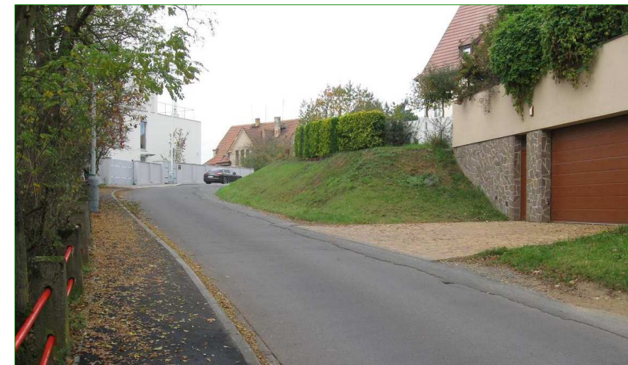
③ Psohlavců-Na Výstupu; nevyhovující rozhledové poměry
