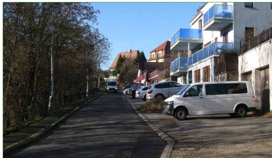
② Psohlavců; nedostatečná šířka pro míjení vozidel
