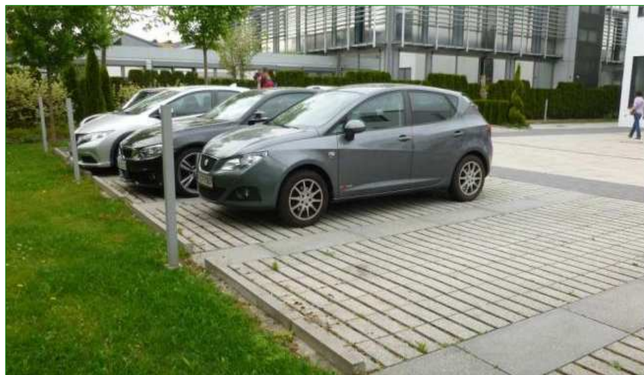
VIZE - úpravy pro zasakování vody
