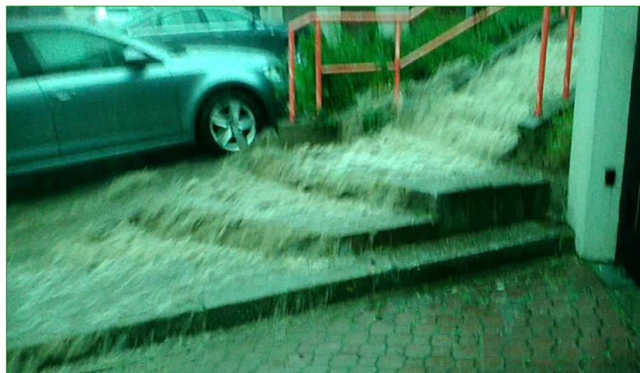
④ Při silnějším dešti odvádí vodu z Ohnivcovy schodiště
